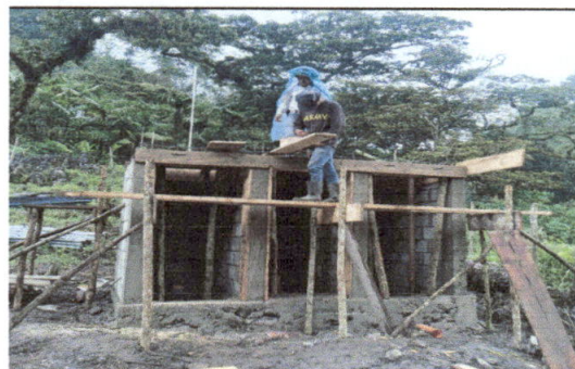
Foto 2: Avance de habilitación de paredes para el servicio de baños.
