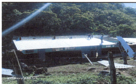
Foto 4: Instalación de cubierta de lámina/troquelada.
