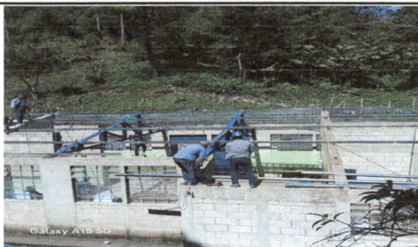
Foto 3: Instalacion de estructura de soporte.
