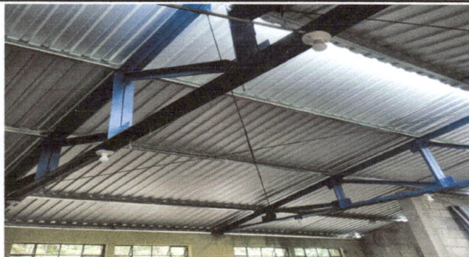
Foto1: Mantenimiento de estructura metalica con pintura anticorrosivo.
