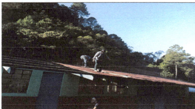
Foto 5: Desinstalación de lámina normal.
